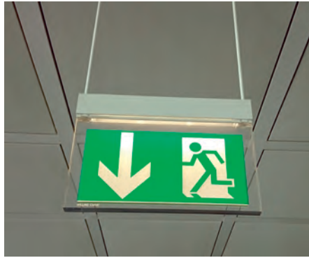
EIN FUNKTIONIERENDES Fluchtwegkonzept ist Teil des baulichen Brandschutzes
