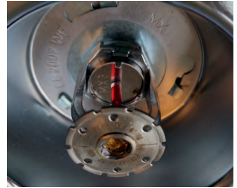
ZUM BEREICH des anlagentechnischen Brandschutzes gehören Feuerlöschsysteme
